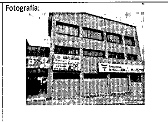
Descripción: FACHADA POSTERIOR
