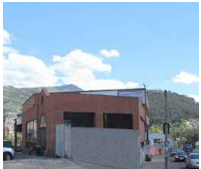
Edificio Cucasa Quito
