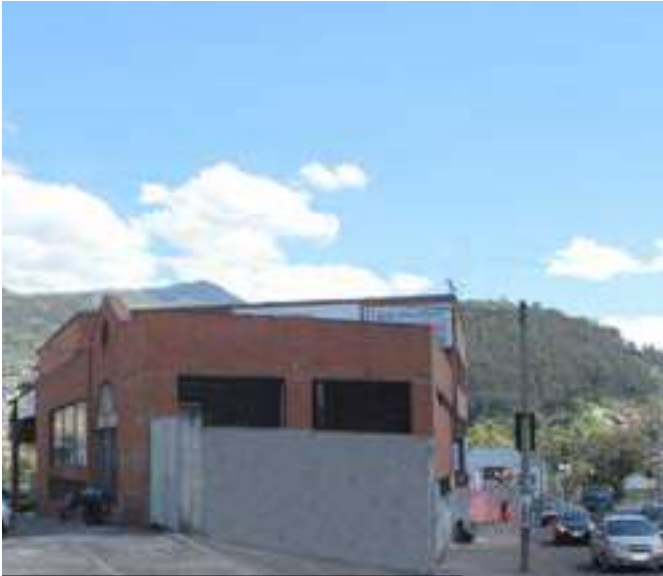
Edificio Cucasa Quito
