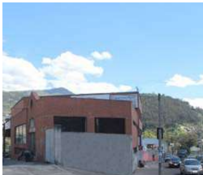
Edificio Cucasa Quito
