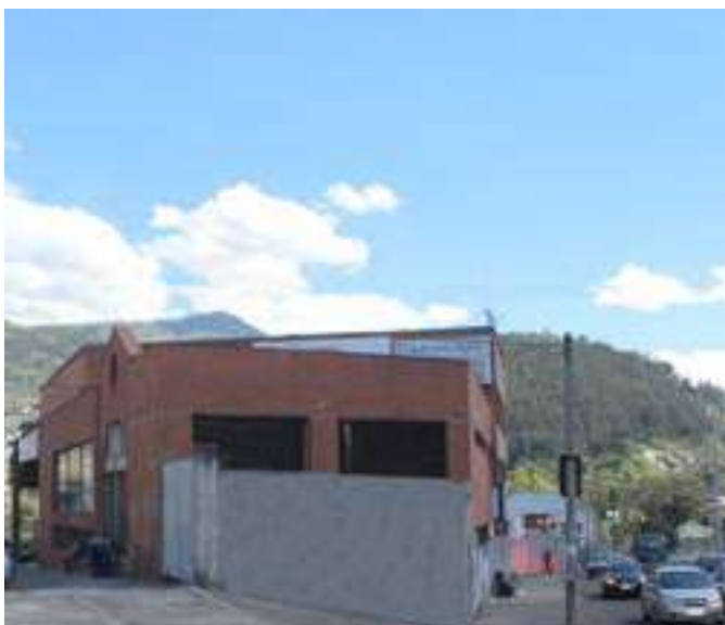
Edificio Cucasa Quito
