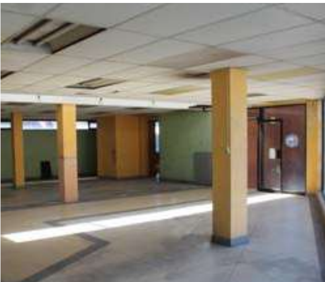
Edificio Cucasa Quito
