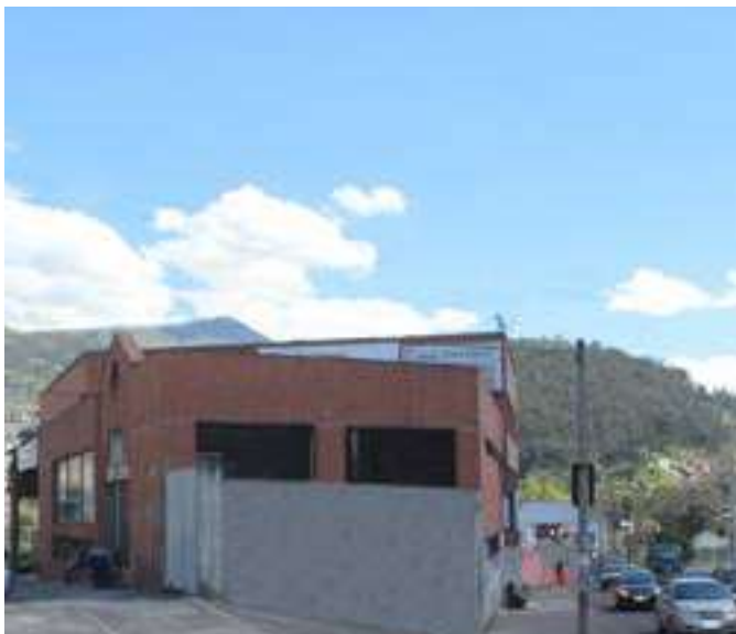
Edificio Cucasa Quito
