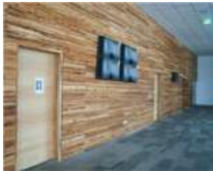
Ubicación de panel gigante al ingreso de auditorio.
