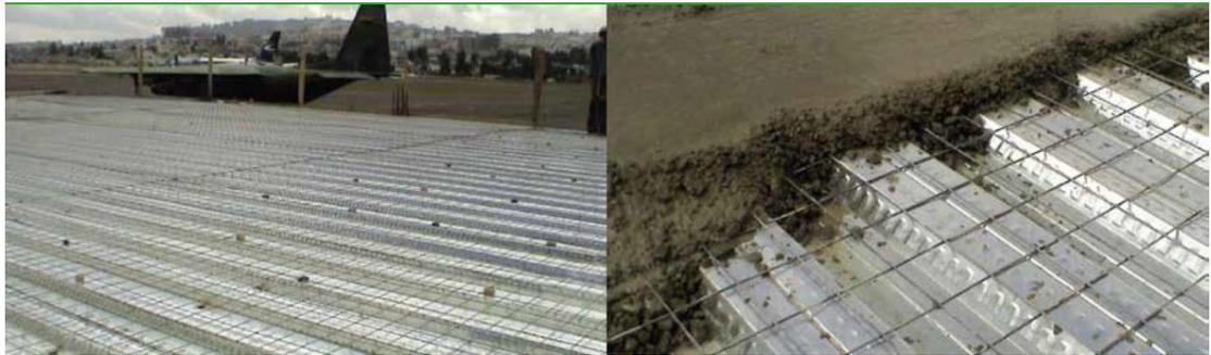
**Figura 2.** Losa Tipo Deck
